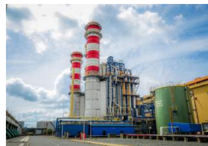
Nhà máy điện Cà Mau 2 (Cà Mau)
