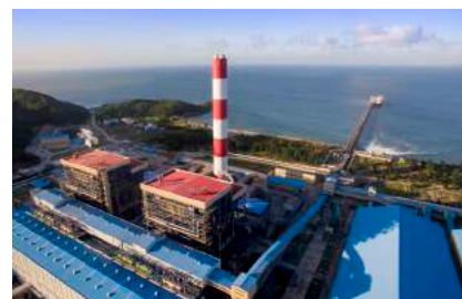
Nhà máy điện Vũng Áng 1 (Hà Tĩnh)
