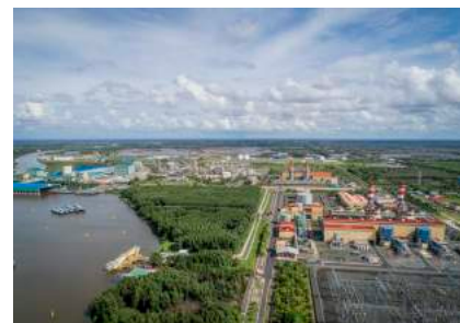
Nhà máy điện Cà Mau 1 (Cà Mau)
