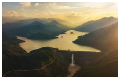
Nhà máy Thủy điện Đakdrinh (Quảng Ngãi)
