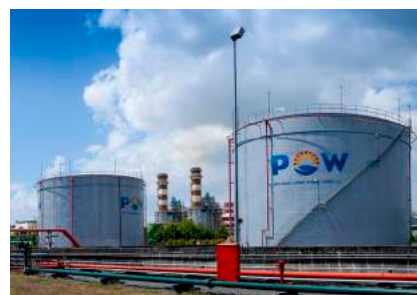
Nhà máy điện Nhơn Trạch 2 (Đồng Nai)
