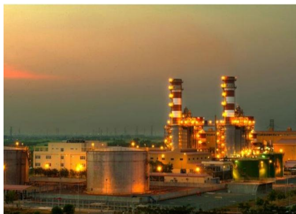
Hình 7: Nhà máy điện Nhơn Trạch 2
