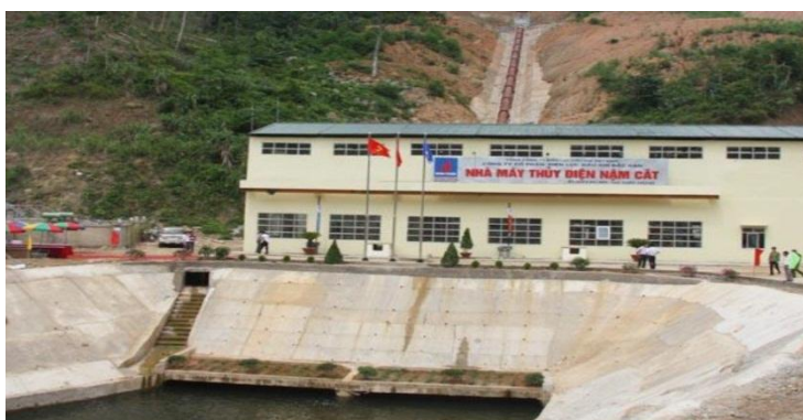
Hình 10: Nhà máy Thủy điện Nậm Cắt
