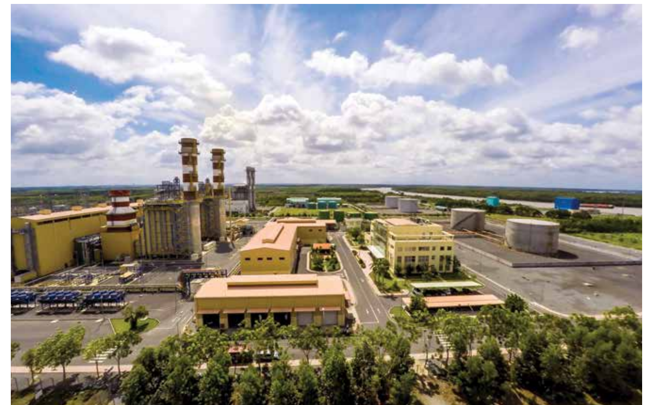
PV Power Nhơn Trạch
