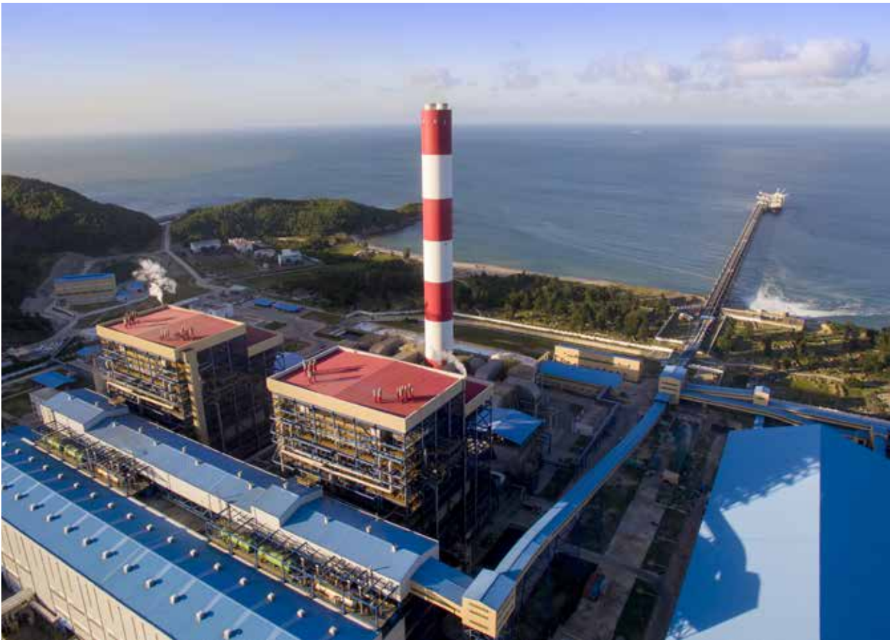
PV Power Vũng Áng
