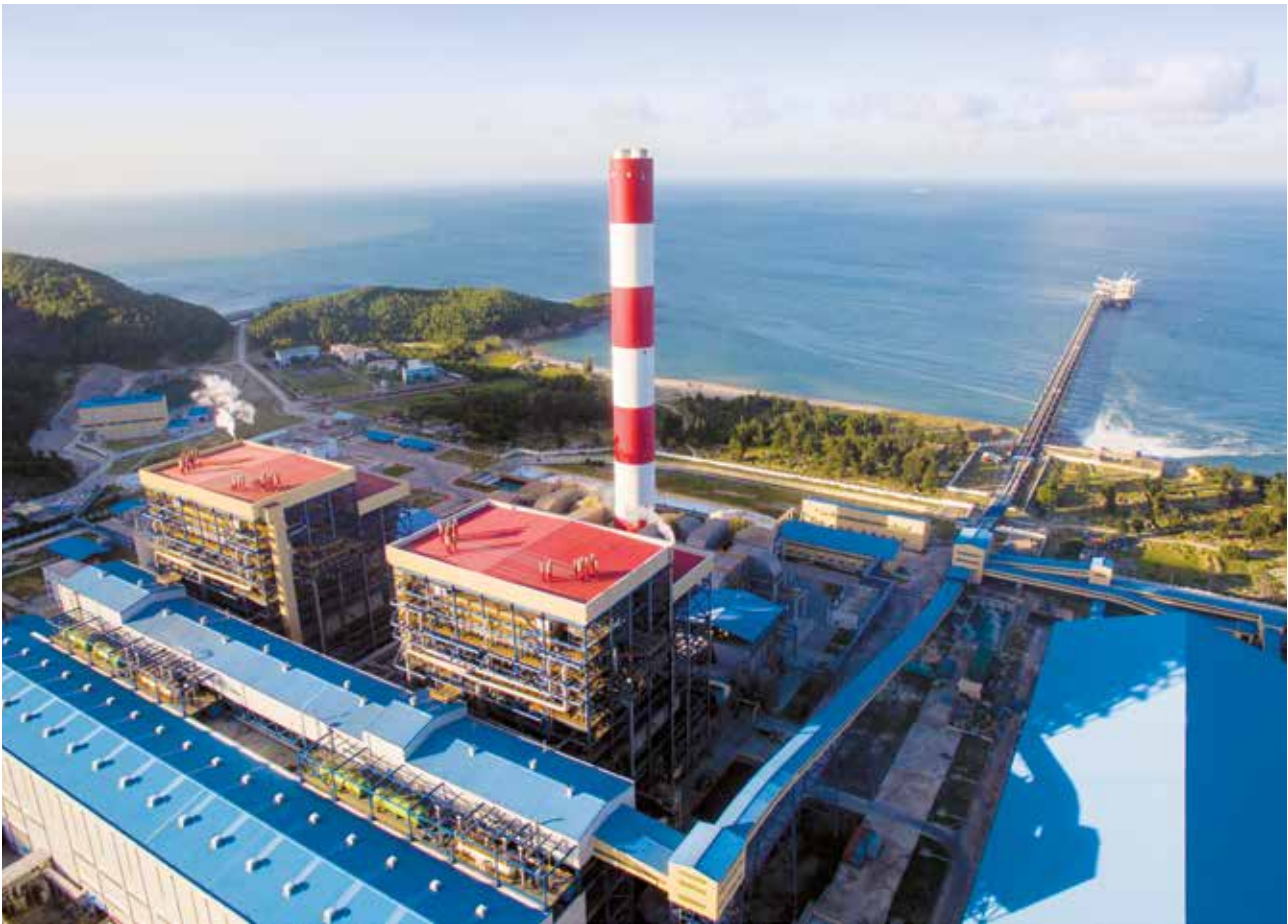
PV Power Vung Ang
