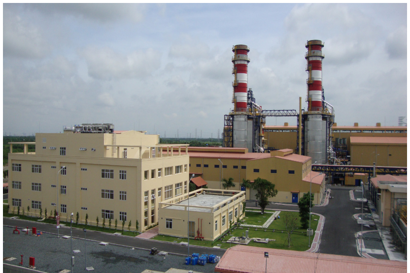
Hình ảnh Nhà máy điện Nhơn Trạch 2
